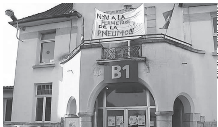
Entrée de l'hôpital de Lens.
